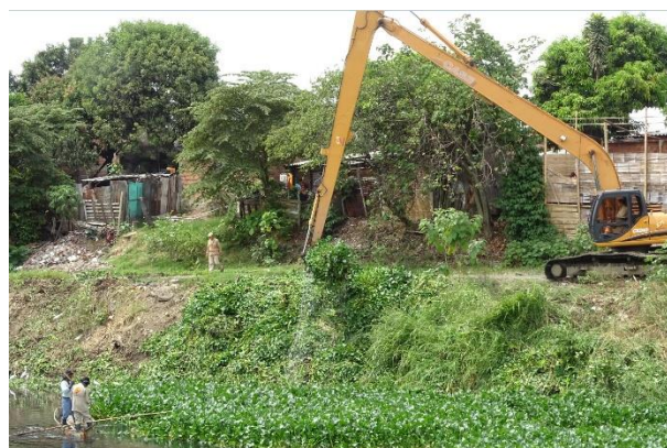
Foto No. 122 Remoción de buchón de agua con una retroexcavadora y la participación de los Dinamizadores Ambientales
